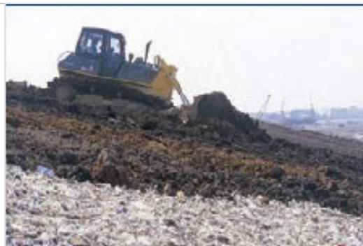
⑥廃棄物埋立処分場（東京都） 写真：東京都環境局
