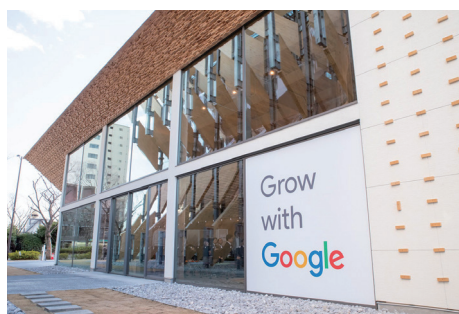
岡山県真庭市から提供された CLT 材で建設された「CLT PARK HARUMI」の外観。サステナブルな構造システムを実現しており、約 1 年後には解体され、岡山県に移築される
