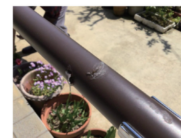
写真1 屋根瓦の傷跡
